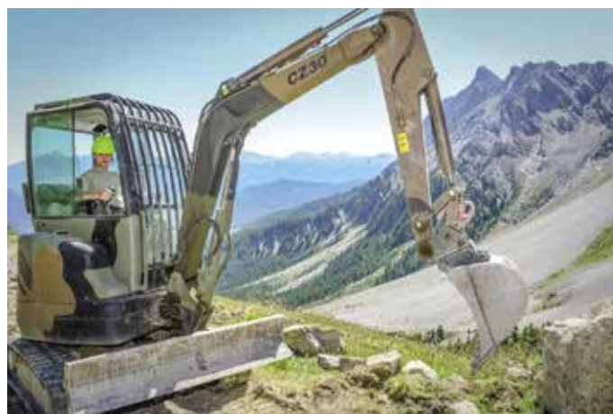
Lavori di sistemazione strada di montagna Bardonecchia
