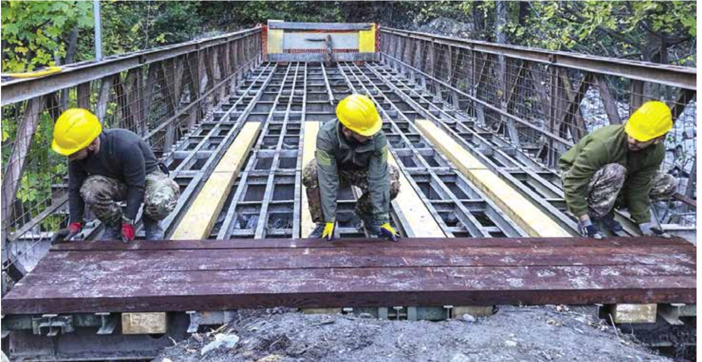
6. Consolidamento ponte Bramafam.jpg
