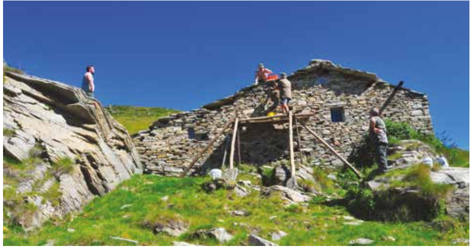
La sistemazione del muro fatiscente della mianda
